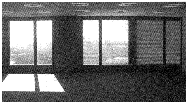
写真-1 ブラインド制御状態比較(巻き上げ, 保護角, 全閉)
