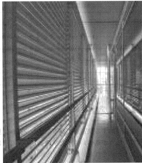
写真-2 バルコニー内部(外部可動ルーバ)
