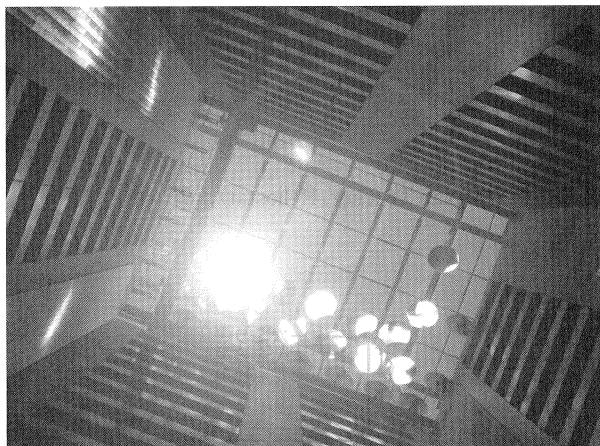
写真-1 採光装置見上げ
