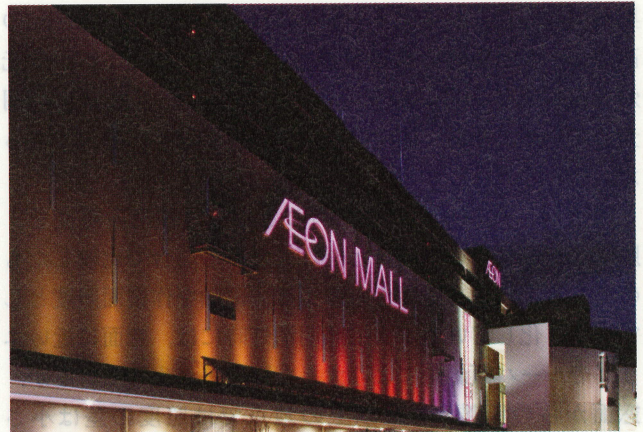
写真-6 LEDによる可変演出照明
